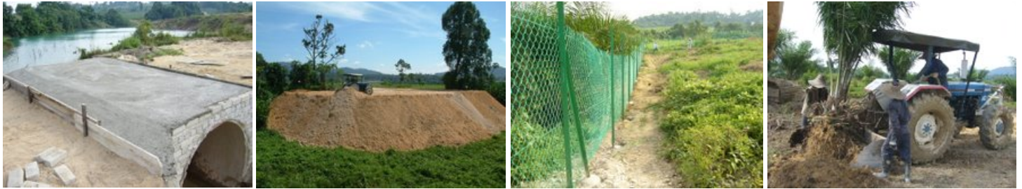
以上是建設中的馬來亞內觀中心照片。
